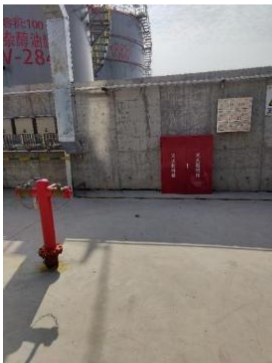
罐区消防栓、灭火器
