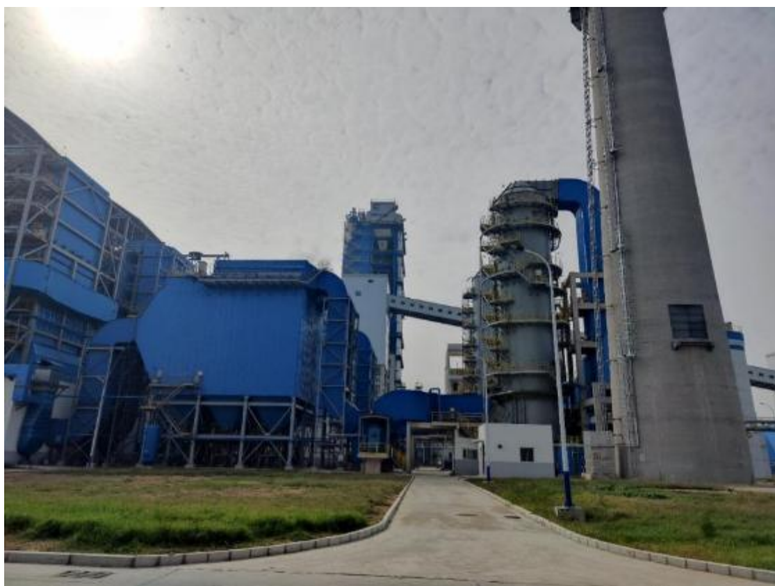
低氮燃烧+SCR 脱硝+电袋复合除尘器+氨-亚硫酸铵法脱硫+排气筒 DA011
