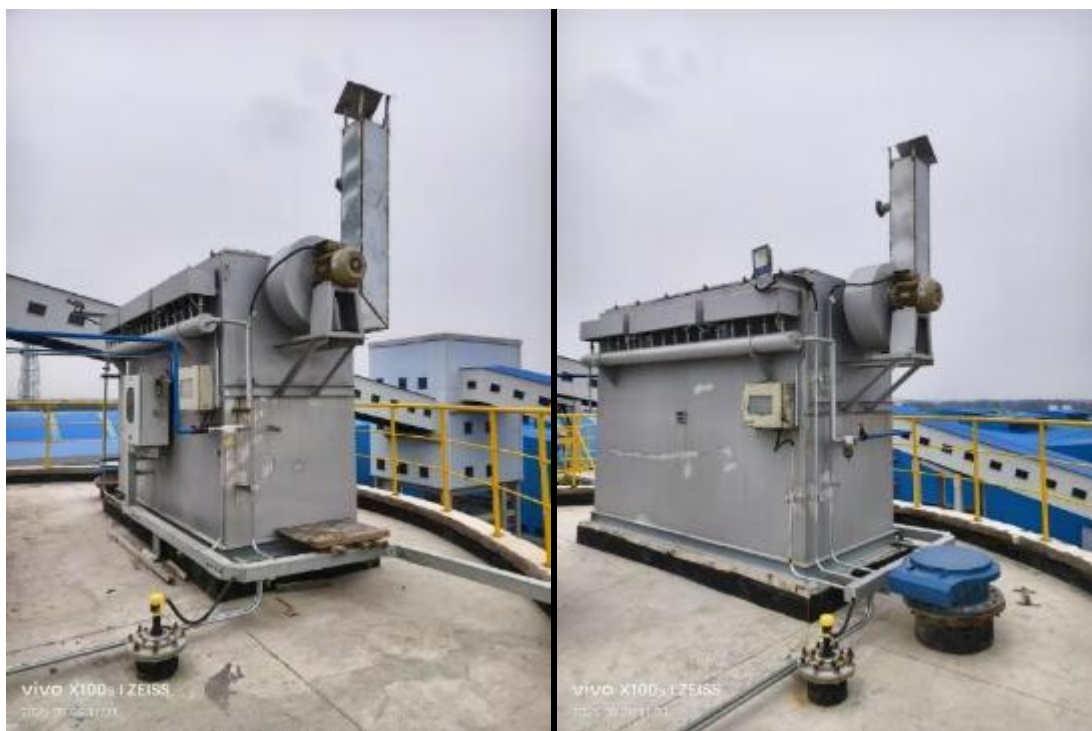
灰仓除尘器 2 套+排气筒 DA012、DA013
