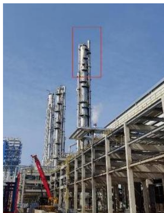
净化工段尾气洗涤塔+排气筒 DA023
