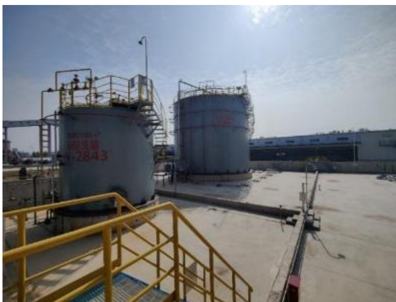
罐区围堰、可燃气体报警装置、导流沟、防渗措施
