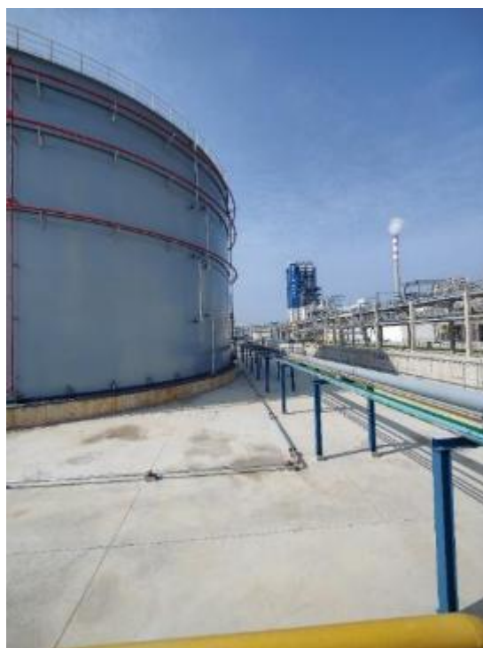
罐区围堰、导流沟、地面防渗
