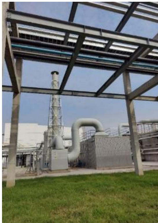
污水处理站生物滴滤+吸附+排气筒 DA030
