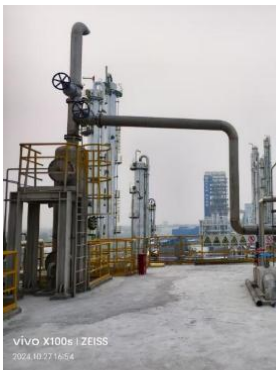
尿素放空空气洗涤塔+排气筒 DA025
