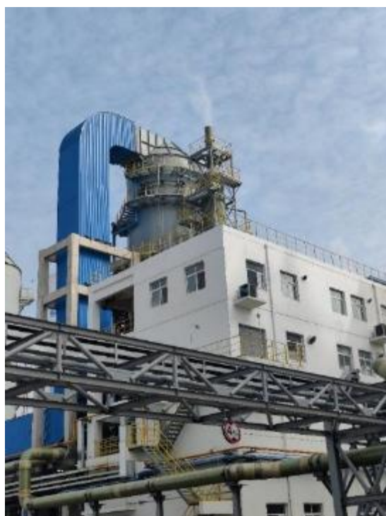
硫酸铵回收系统洗涤塔+排气筒 DA078
