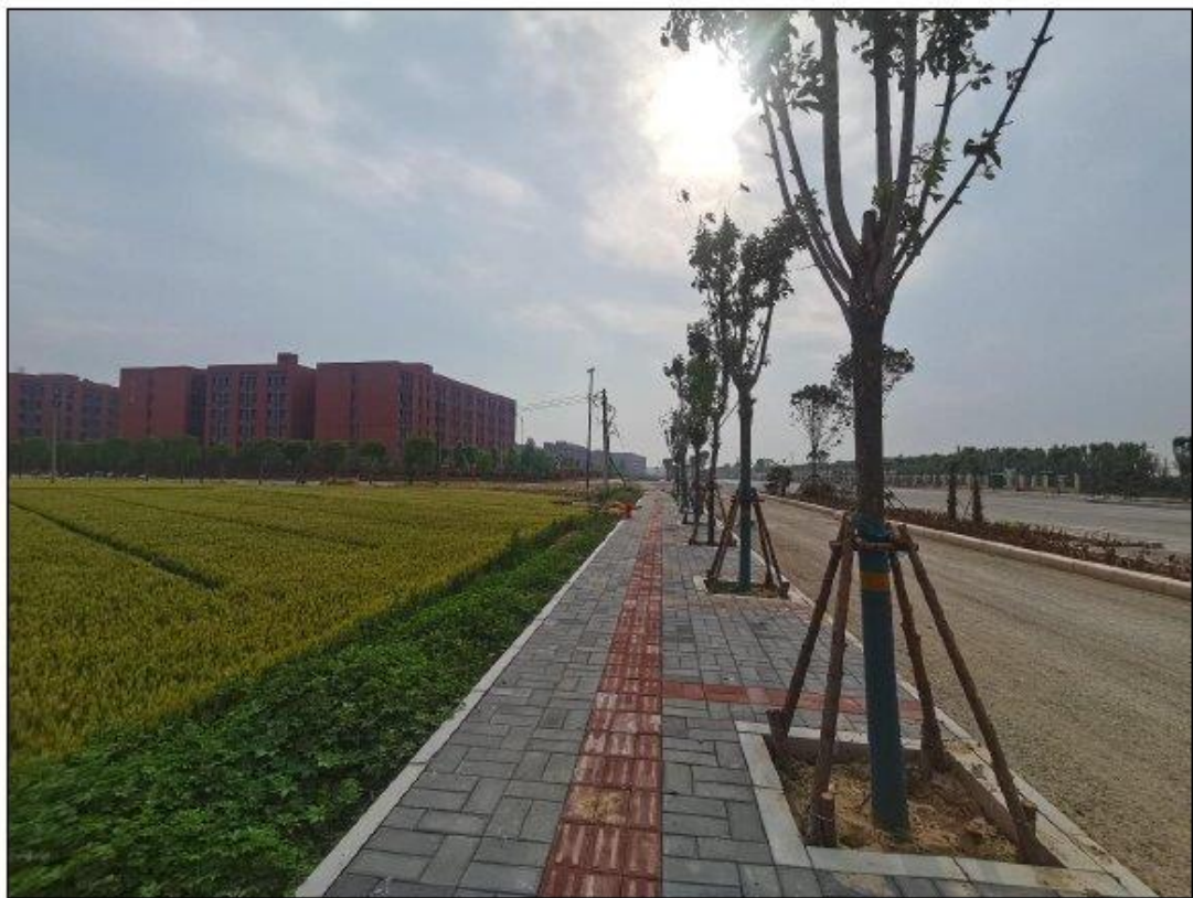
项目北侧 1 号路
