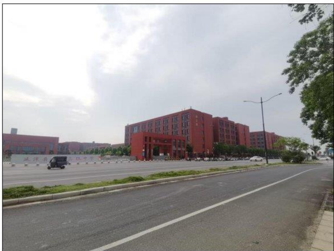
项目西侧延津县第一高级中学(新校区)
